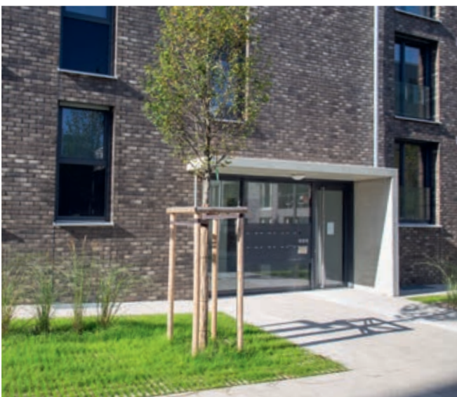
Fassadendetail: Hausfront mit Eingangsbereich
