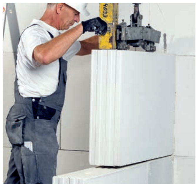
Bild 24 Vermauern von KS XL-Rasterelementen mit Versetzgerät
