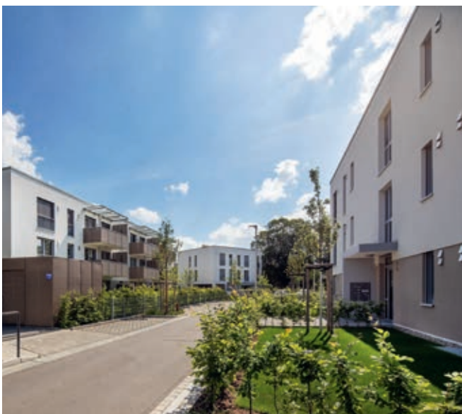
Ausreichende Freiflächen vor den Hauseingängen lassen den Bewohnern Raum.
