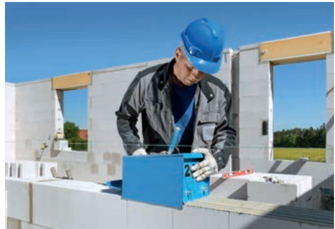
Bild 23 Aufziehen des Lagerfugenmörtels mit dem Mörtelschlitten
