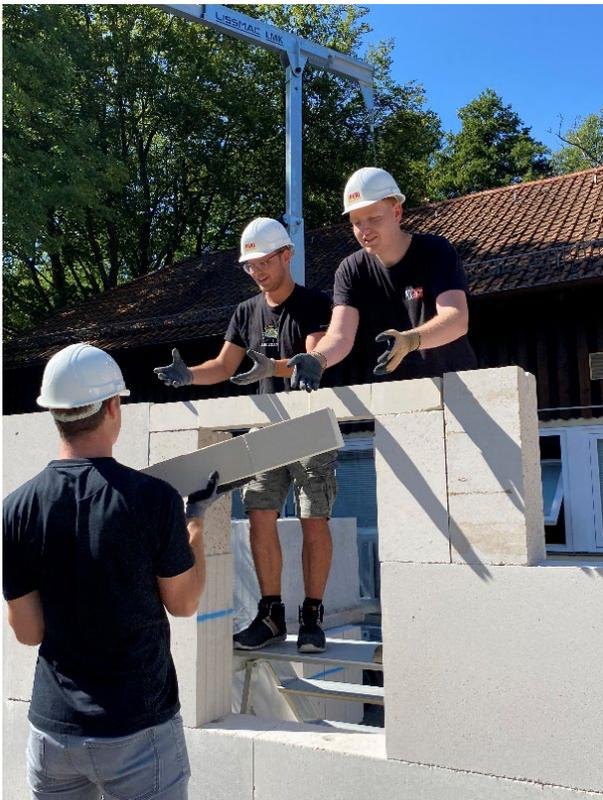
Trockenes Versetzen von KS XL-Planelementen in einer Giebelsituation.
