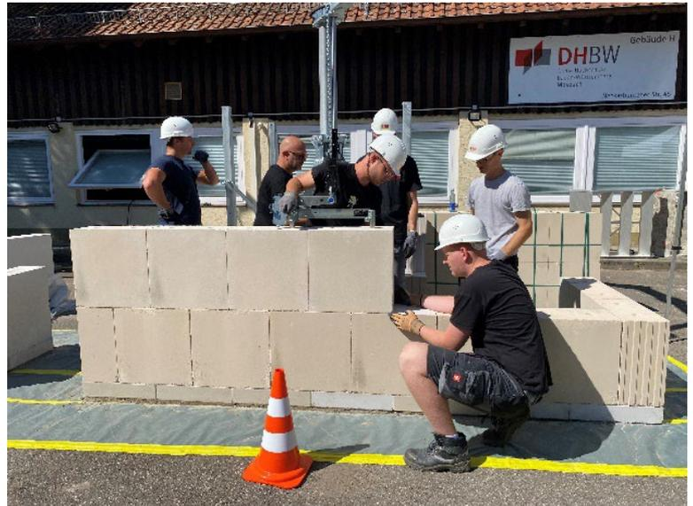
Trockenes Versetzen von Planbauplatten (PPpl) aus Porenbeton.
